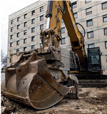
Abbruch des Hauses an der Tauernstraße
