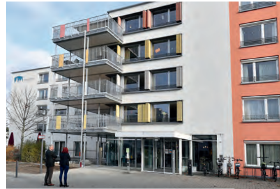
Die neuen Balkone bieten einen schönen Lebensraum im Freien
